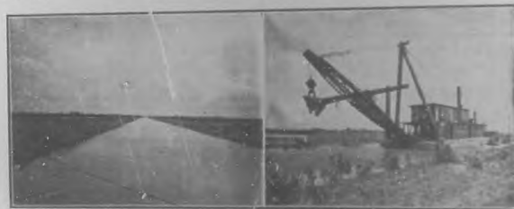
Nuevitas.—Canal que une las bahías Mayanabo y Savinal.—Draga "Nuevitas".
